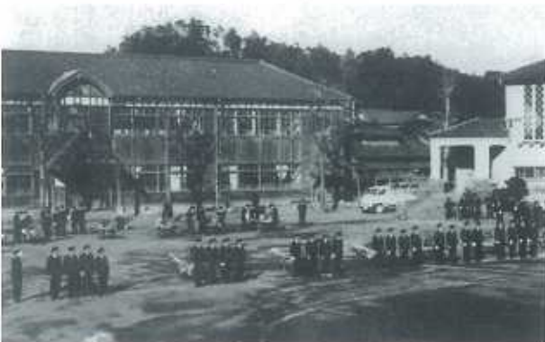
昭和30年代の消防点検（第一小学校）
