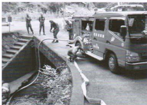
水を吸い上げるポンプ車両
